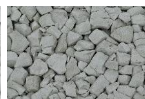
転圧後 (1 t 振動ローラー 4 回後)
