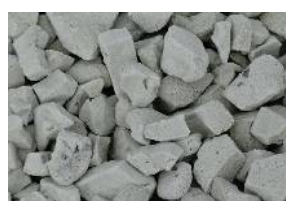
転圧前 (敷き均し・巻き出し)
