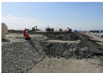
▲サンドウィッチ式施工
