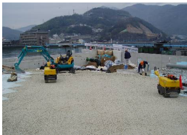
▲スーパーソール施工完了
