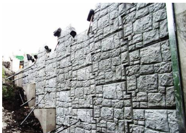
▲補強土壁外観
