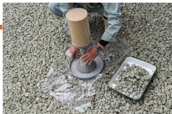
▲現場密度試験(砂置換法)
