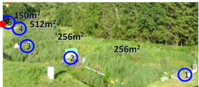
▲施工4年後 ヨシが成長して表面を覆っている
